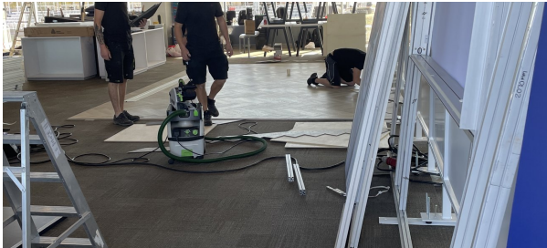
10 月 18 日 — 地板铺好，骨架立起
